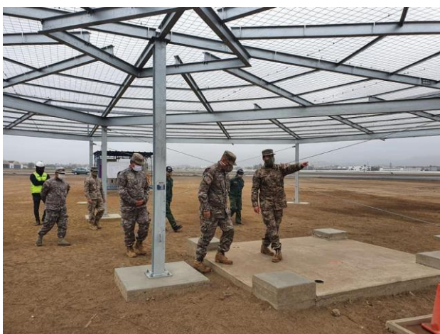
Instalación del Sistema de Radioayudas FAP
